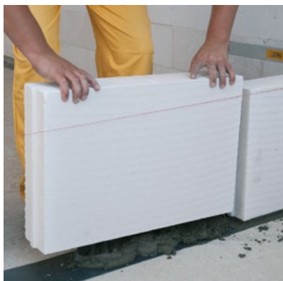
Sekantis blokelis dedamas vertikales siūles patiekiant neužpildytas skiediniu - jį pakeičia iškišų ir išėmų sistema.
