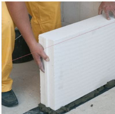
Pirmas blokelių sluoksnis yra dedamas ant tradicinio skiedinio, nepamirštant izoliacijos nuo drėgmės.
