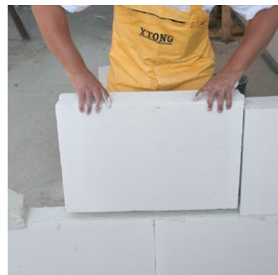
Mūrijant sekantį sluoksnį, reikia nepamiršti apie vertikalų siūlių prakeitimą.
